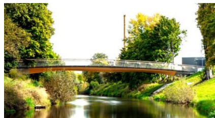
Integrale Holzbrücken, seit 2019 Weinstadt, 2019 mit Cheret Bozic
